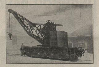
Grue pivotante, à commande à bras, à volée réglable et amovible et contrepoids à écartement fixe, sur vagon à 4 essieux.
