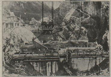
Grue à Câble avec dispositif de coulage du béton pour la construction du barrage du Wäggital
