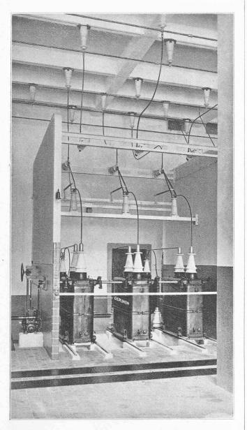
Fig. 30. - Vue d'un départ à 36 000 volts.
