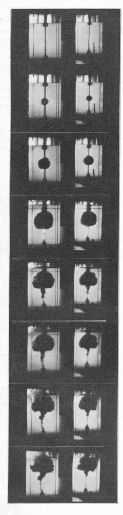
Fig. 1. — Formation du «piston d'huile» lors d'une coupure de 7000 kVA dans un interrupteur dans l'huile. Quelques vues d'une prise au ralenti, à raison de 300 images par seconde.
