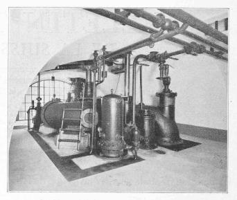
Fig. 16. — Turbine hydraulique et appareils auxiliaires.
