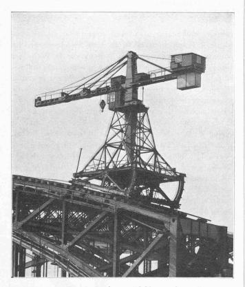
Fig. 2. — Grue à plateforme réglable pour le montage des ponts métalliques.
