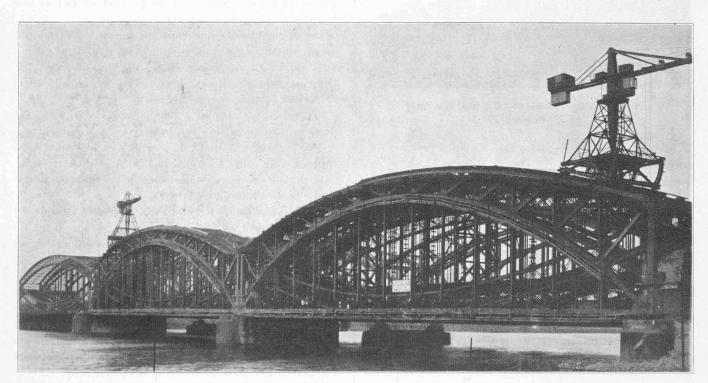
Fig. 1. — Nouveau pont sur l'Elbe, monté au moyen de deux grues à plateforme réglable, système des Ardeltwerke.
