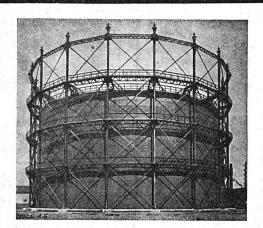
Gazomètre d'une contenance de 50,000 m3.
