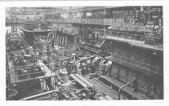
Fig. 3. — Hall de montage pour moteurs Diesel de grande puissance, de MM. Sulzer Frères, S. A., à Winterthour.
