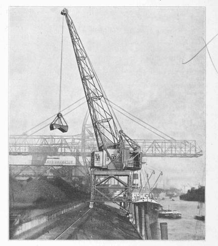
Fig. 3. - Grue de quai, à volée inclinable, dans sa position de portée minimum: 8 m.
