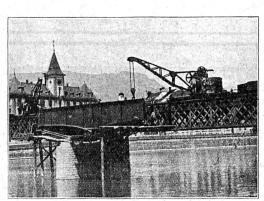
Grue pivotante, sur truck, à volée réglable, force 15 tonnes, utilisée à la réfection d'un pont.
