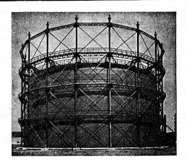
Gazomètre d'une contenance de 50,000 m3.
