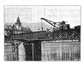
Grue pivotante, sur truck, à volée réglable, force 15 tonnes, utilisée à la réfection d'un pont. Téléphone N° 69 — Adr. télégr.: Fonderie Vevey
