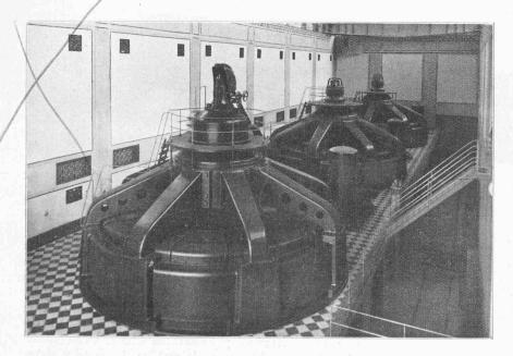
Fig. 10. — Salle des machines de l'usine de Lilla Edet. Turbine Kaplan au premier plan, turbines Lawaczeck au second plan.
