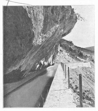
Fig. 3. — Rocher surplombant le canal d'amenée.
