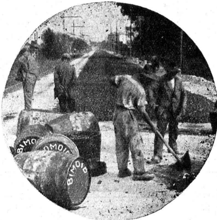
Revêtement par pénétration
