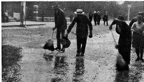
Bimoïdage d'une chaussée goudronnée
