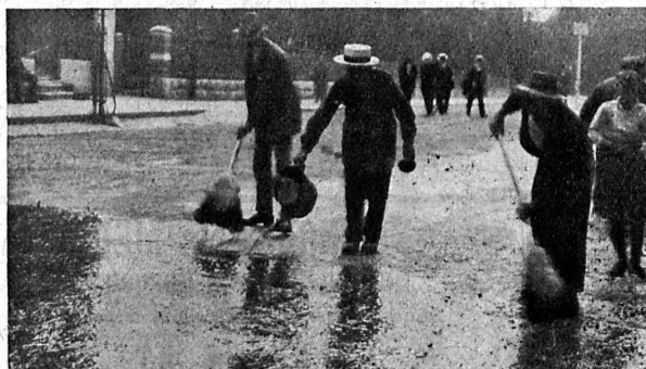
Bimoïdage d'une chaussée goudronnée
