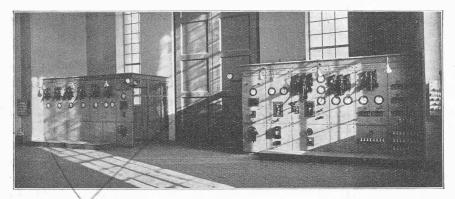
Fig. 17. — Tableau des services auxiliaires.
