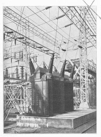
Fig. 16. — Disjoncteurs à 120 000 volts.
