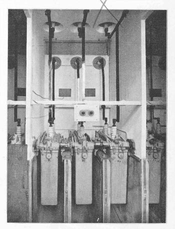
Fig. 13. — Disjoncteurs 11 000 volts.
