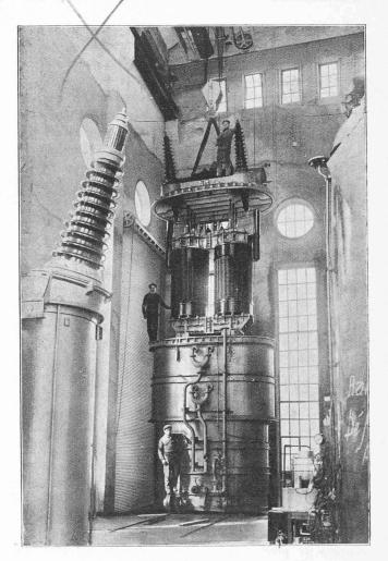
Fig. 8. — Transformateur démonté.
