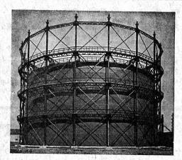
Gazomètre d'une contenance de 50,000 m3.
