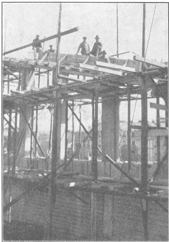
Fig. 8. — Coffrage d'un pignon.
