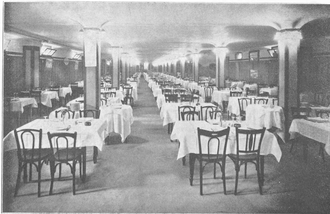
Fig. 7. — Sous-sol aménagé en restaurant.
