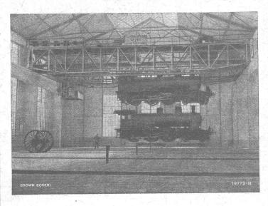
Essai de charge d'un pont roulant destiné à soulever des locomotives dans les Ateliers de réparations d'Yverdon des Chemins de fer fédéraux suisses. Force de levage: 120 t.; vitesse de levage: 2 m/min.
