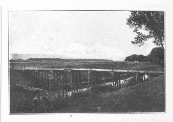
Fig. 5. — Pont de pilotis de 40 mètres de longueur, construit en 32 heures, préparation des bois et pont de service 25 heures.
