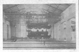
Pont roulant électrique de 120 tonnes livré aux Ateliers des C. F. F., à Yverdon. — Vue prise au cours des essais de réception, les deux locomotives remplaçant les charges usuelles de rails.
