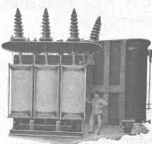
TRANSFORMATEUR TRIPHASÉ DE 7000 KVA - 90000/22000 VOLTS MONTAGE EXTÉRIEUR
