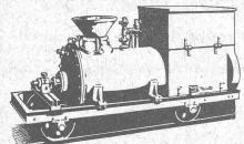
Machine à injection de ciment.
