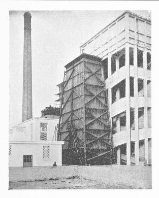
Fig. 12. — Aile ouest de l'abattoir industriel. Rampe à bestiaux, tour de réfrigération et chaufferie.
