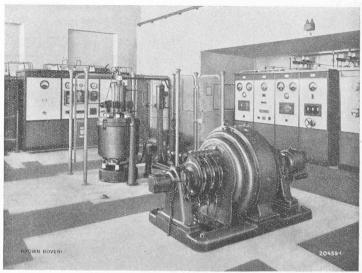
Fig. 4. — Intérieur de la sous-station automatique de Saint-Légier,
