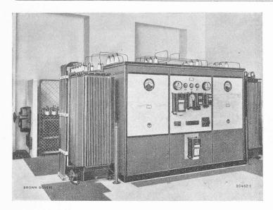
Fig. 3. — Tableau à courant alternatif de la sous-station automatique de St-Légier.
