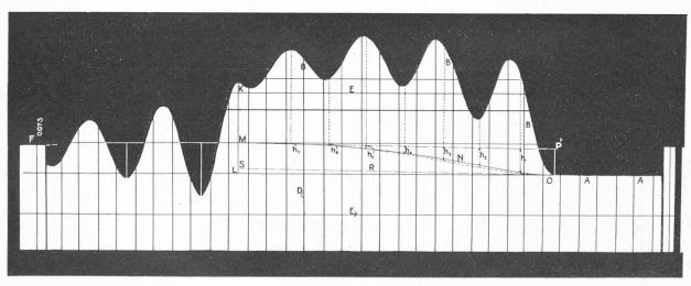
Fig. 17. — Graphique fourni par l'appareil Gibson lors de l'essai du groupe Nº 16 de l'Usine Nº 3 de Niagara,
