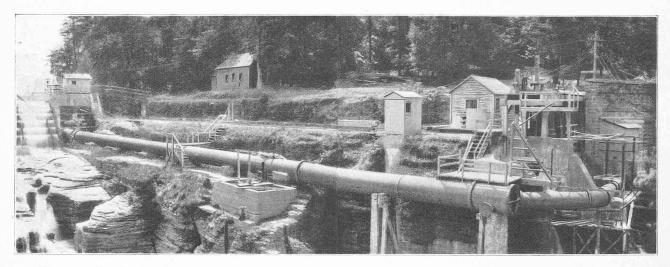
Fig. 13. — Vue de la conduite du laboratoire d'hydraulique de l'Université de Cornell, avec, au milieu, l'appareil Gibson.
