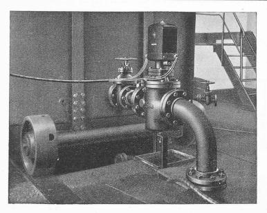
Fig. 2. — Transmetteur de débit à distance, en fonctionnement.
