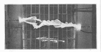
Fig. 5. — Arc de 3,2 m. de long.
