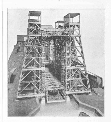
Fig. 4. — Maquette, à l'échelle 1 : 50, d'un projet d'élévateur à bateaux à *Nieder finow*, sur le canal de Hohenzollern.
