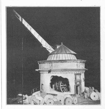
Fig. 1. — Maquette de la vieille grue d'Andernach, construite en 1554-57 et qui servit jusqu'à la fin du XIX<sup>e</sup> siècle à charger les meules taillées dans la lave basaltique.
