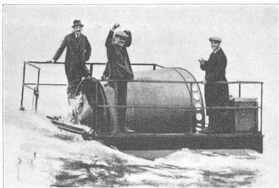
Fig. 3. — Turbine Suess, à moitié immergée.
