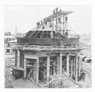
Fig. 2. — Montage de la toiture.
