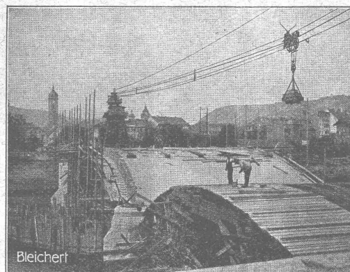
Grue à câble « Bleichert » pour la construction de ponts.
