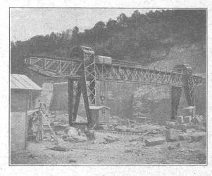
Pont roulant électrique pour carrières. - Force: 30 tonnes.
