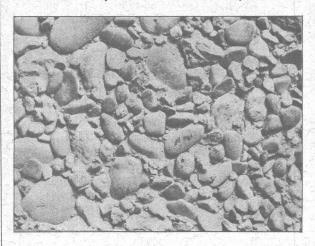
jet d'eau à haute pression et la structure naturelle du béton apparaît immédiatement. En mettant en œuvre, pour les surfaces, des matériaux choisis, on obtiendra les effets les plus variés. Si une surface de béton doit être enduite pour une raison quelconque, le traitement au Contex fournira la base garantissant l'adhésion parfaite de l'enduit.
