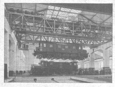
Essai de charge d'un pont roulant destiné à soulever des locomotives dans les Ateliers de réparations d'Yverdon des Chemins de fer fédéraux suisses. Force de levage: 120 t.; vitesse de levage: 2 m/min.
