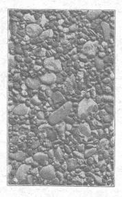
Si une surface de béton doit être enduite pour une raison quelconque, le traitement au Contex fournira la base garantissant l'adhésion parfaite de l'enduit.
