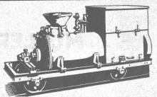
Machine à injection de ciment.
