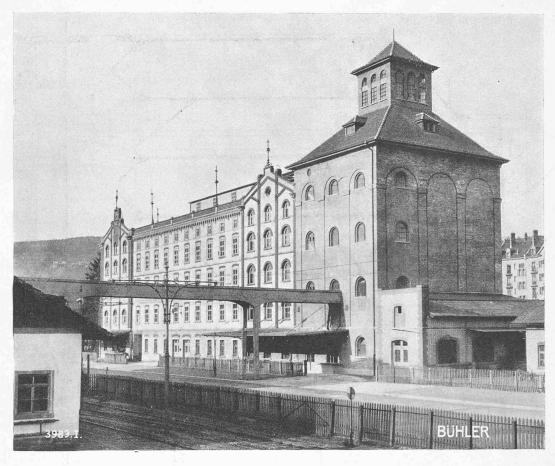
Fig. 1. — Silo de la Minoterie Coopérative des Sociétés Suisses de Consommation, à Zurich. Vue d'ensemble du moulin avec le silo et la passerelle pour le transporteur à ruban.
