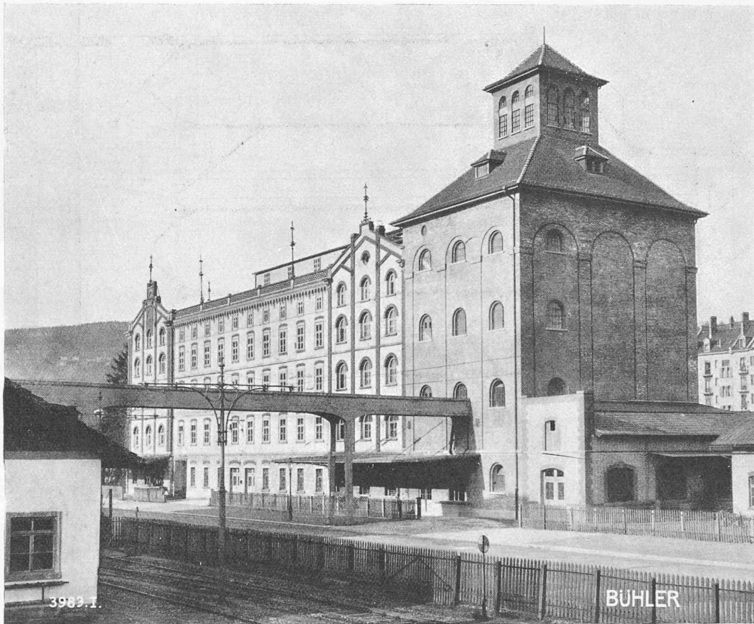
Fig. 1. — Silo de la Minoterie Coopérative des Sociétés Suisses de Consommation, à Zurich. Vue d'ensemble du moulin avec le silo et la passerelle pour le transporteur à ruban.
