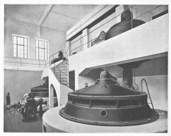
Fig. 3. — Transmission par engrenages Krupp de l'usine hydroélectrique de Baiersdorf-Wellerstadt, près d'Erlangen.
