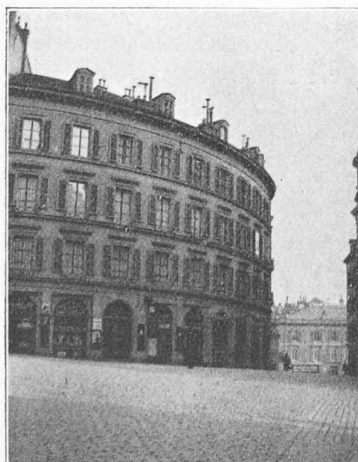
Groupe de bâtiments de la place St-Pierre ; état présent.
