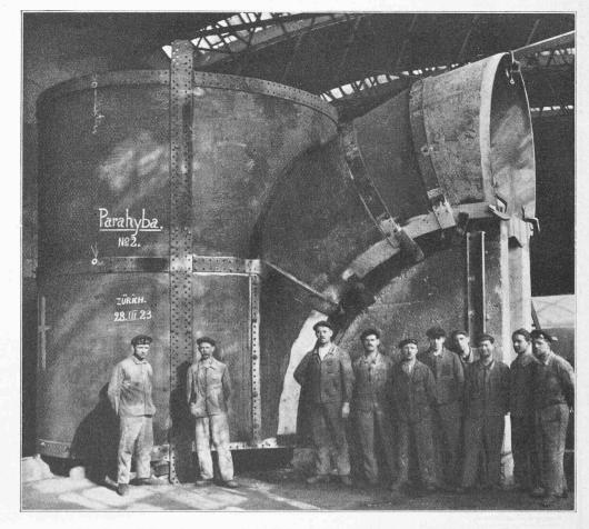
Fig. 4. — Collecteur et tronçon de bâche spirale de l'usine de Parahyba (Brésil).  $H=31,7~\rm m.$  ;  $\,Q=91,3~\rm m^3/sec.$  ;  $N=32\,500~\rm ch.$  ;  $n=125\,\rm t/min.$
