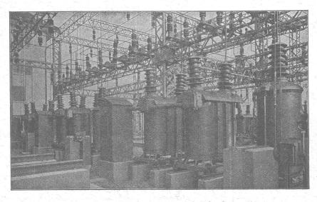
Sous-station des C. F. F. à Emmenbrücke (Lucerne). Groupes de disjoncteurs 65 kv. Gros appareillage
