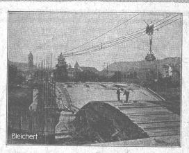
Grue à câble « Bleichert » pour la construction de ponts.
