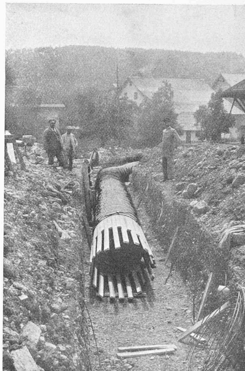
Fig. 2. — Construction continue, sur place, d'une conduite en bois.
