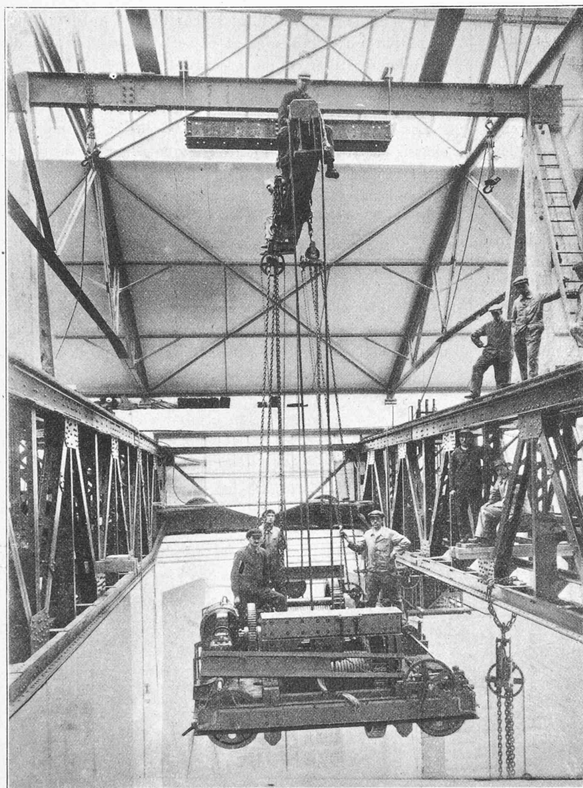
Fig. 3. — Une des phases du montage d'un des chariots-treuil principaux.
