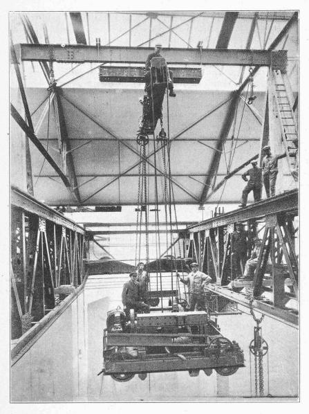
Fig. 3. — Une des phases du montage d'un des chariots-treuils principaux.
