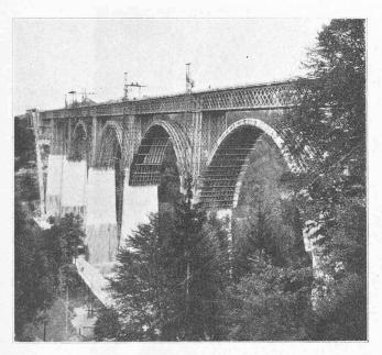
Fig. 6. — Etat des travaux de reconstruction du viaduc de Grandfey, au 20 octobre 1925.
