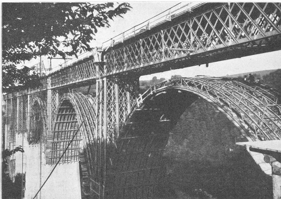
Fig. 5. — Etat des travaux de reconstruction au 6 octobre 1925.
