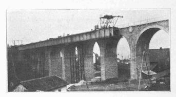
Fig. 12. — Démolition du pont métallique.
