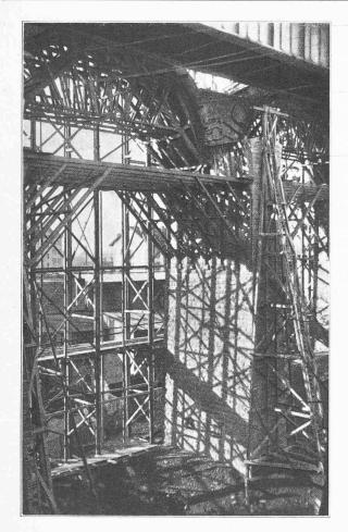
Fig. 15. — Cintres triangulés sous le demi-pont aval et pont de service.
