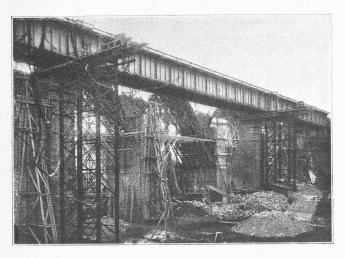
Fig. 10. — Premier ripage du tablier métallique et construction du demi-pont, côté lac.
