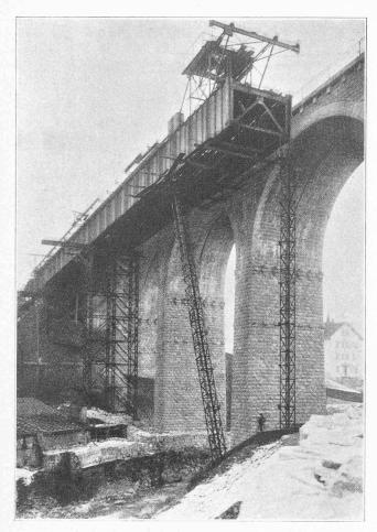
Fig. 13. - Démolition du pont métallique.
