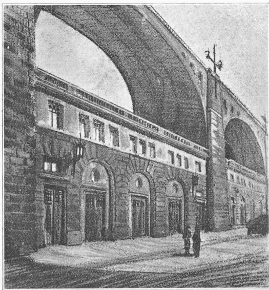
Fig. 15. — Vue des constructions sous le pont Chauderon.
