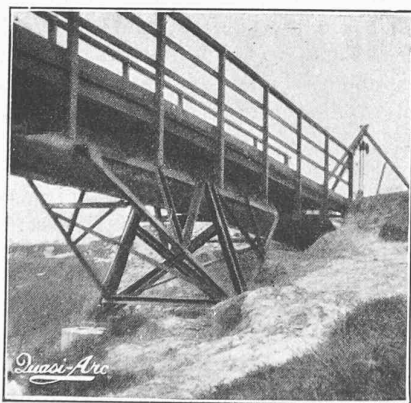
Fig. 3. — La passerelle, après montage du tablier et du garde-corps. La figure représente aussi clairement une des palées.
