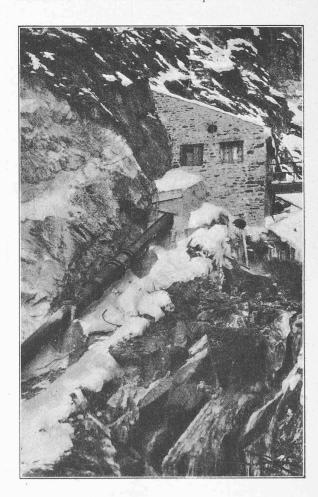
Fig. 8. — Chambre des vannes. A gauche, rocher gunité.
