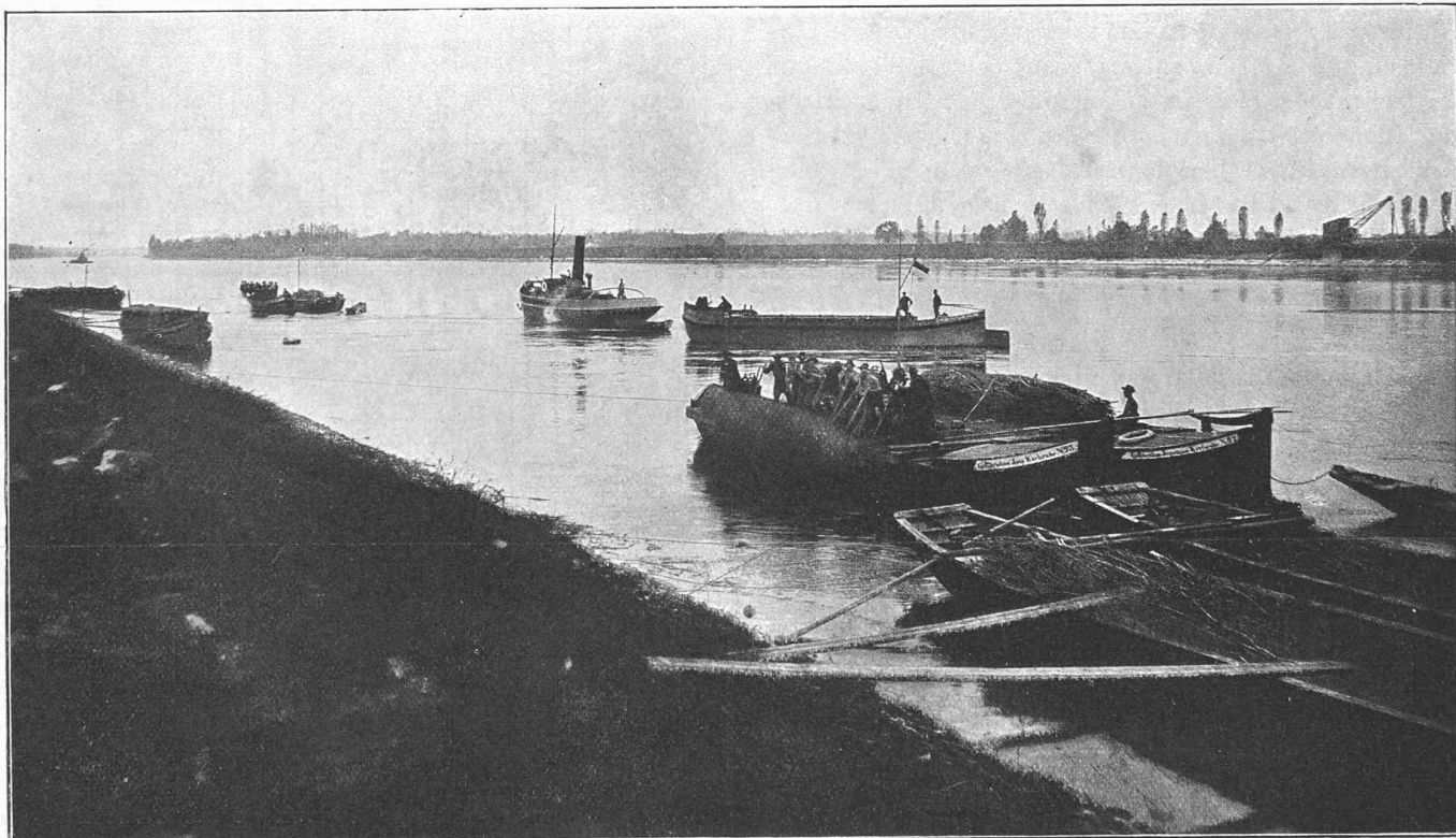
Fig. 2. — Chantier aux environs de Maxau.
